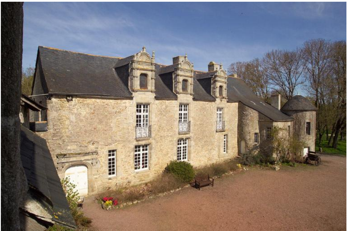
Guérande, château de Careil, corps central, état actuel
