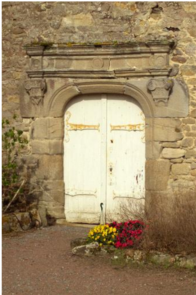
Porte sur l'élévation antérieure du logis.
