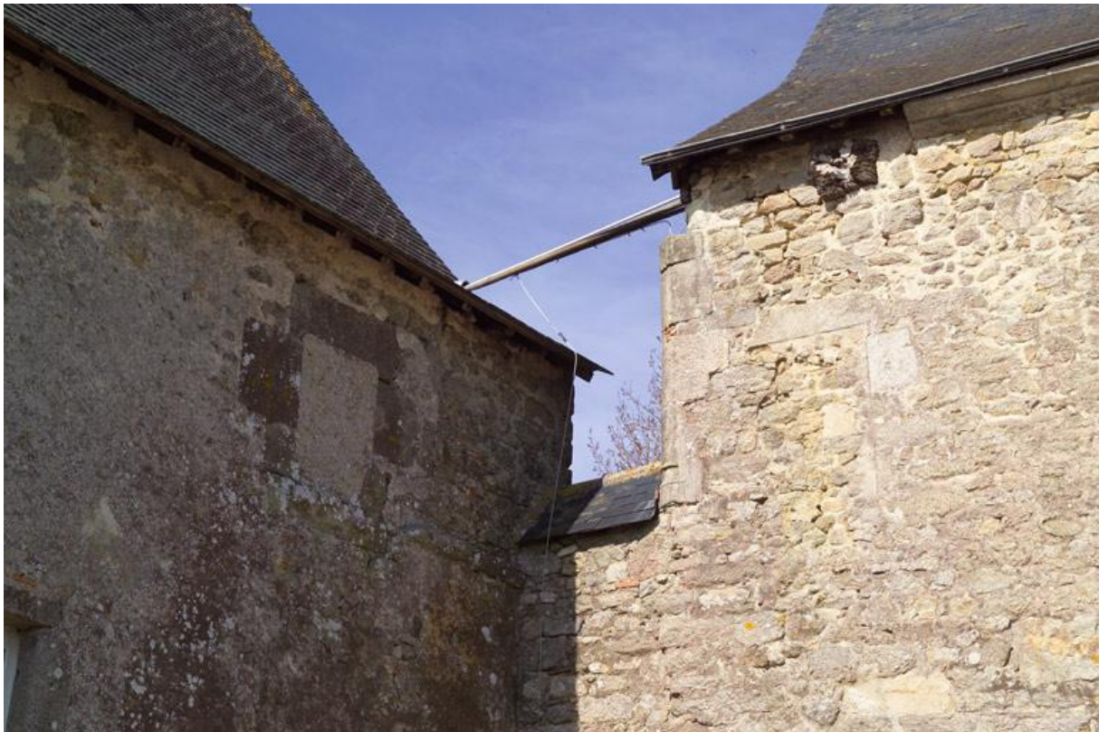
Détail de la partie gauche de l'élévation antérieure du logis
