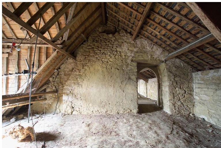
Mur de refend ouest dans le comble au-dessus de la petite pièce centrale du logis
