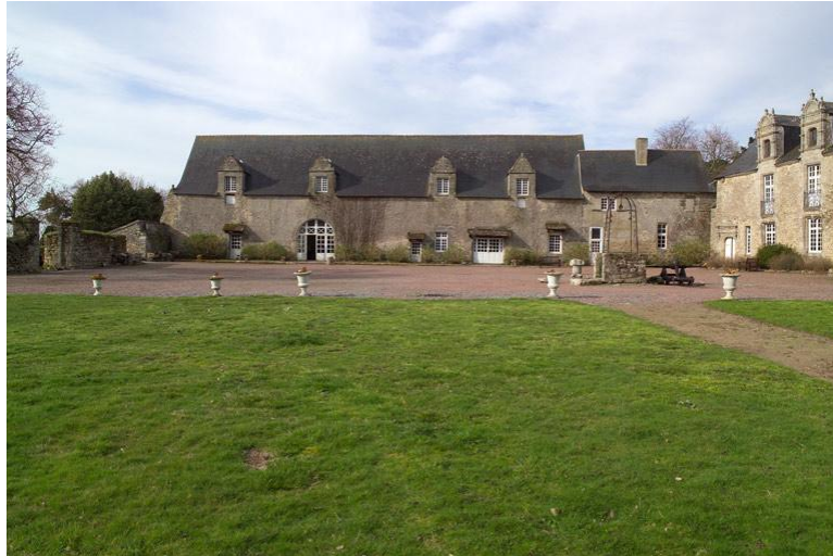
Élévation droite des anciennes écuries
