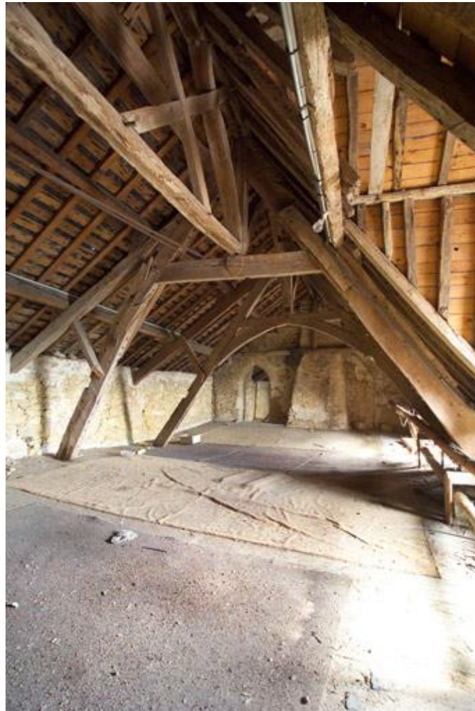
Ferme à aisseliers courbes au-dessus de la grande pièce du logis
